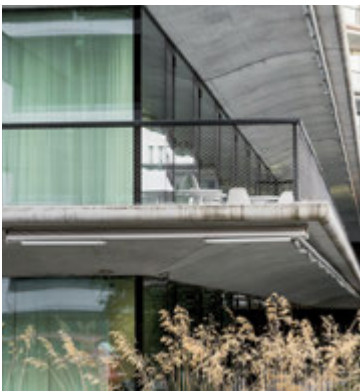
Absturzsicherung mit Metallnetz und Handlauf aus Metall Actelion, Allschwil, Herzog & de Meuron, 2007 - 2013
