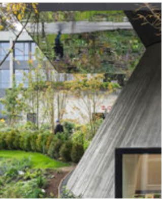
Polierte Metalldeckenuntersicht mit spiegelndem Effekt. Helvetia Erweiterung West, St. Gallen, Herzog & de Meuron, 2013
