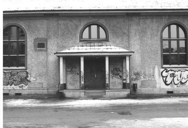
Eingang Pausenplatz (Nordost)
