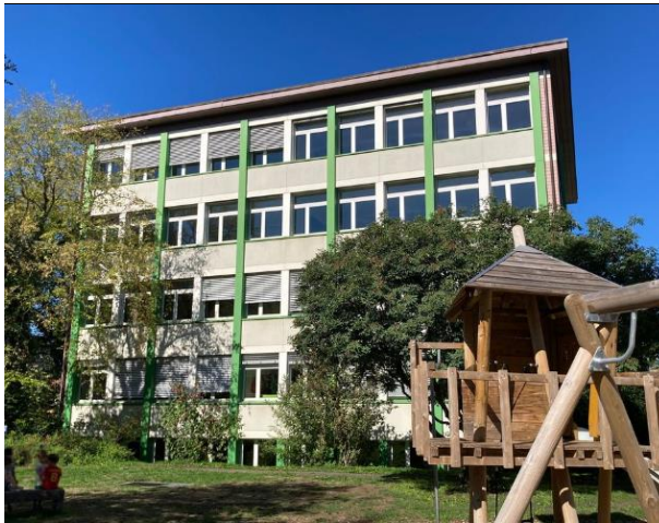
Abbildung 37: Schulhaus Birspark 2 - Schulstrasse 35 (Quelle: www.schulen-birsfelden.ch )
