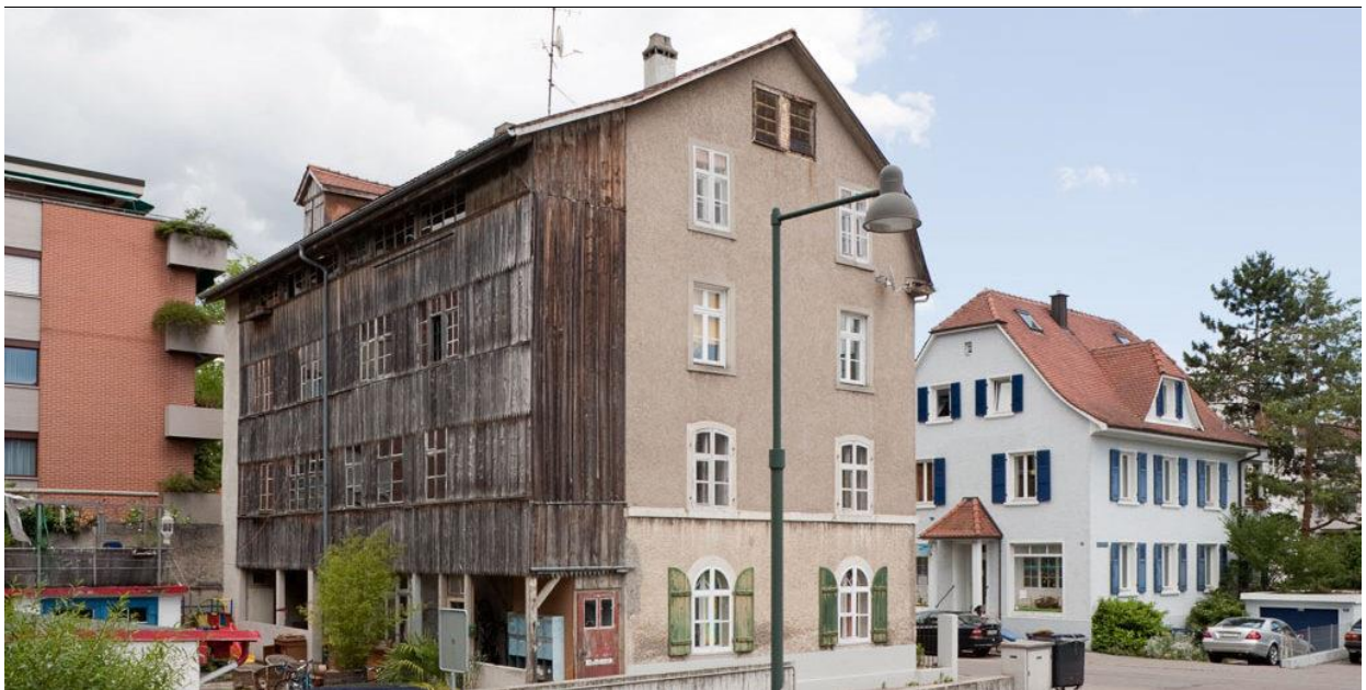
Abbildung 45: Erhaltenswertes Gebäude Schulstrasse 9 (architekturbasel.ch)
