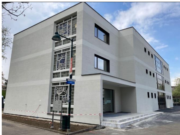
Abbildung 32: Schulhaus Birspark 1 - Schulstrasse 33 (Quelle: www.schulen-birsfelden.ch )
