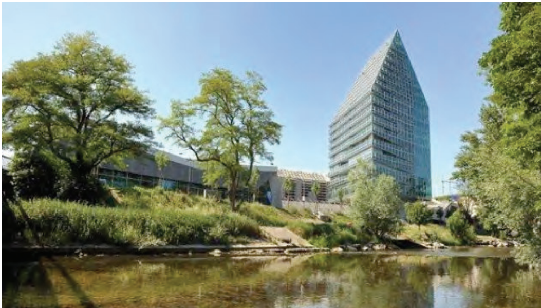
Abb. St. Jakob-Turm (71 Meter Gebäudehöhe)
